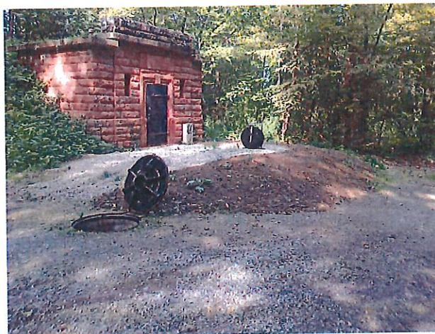
Réservoir de Rosenwiller déconnecté et regard de régulation
