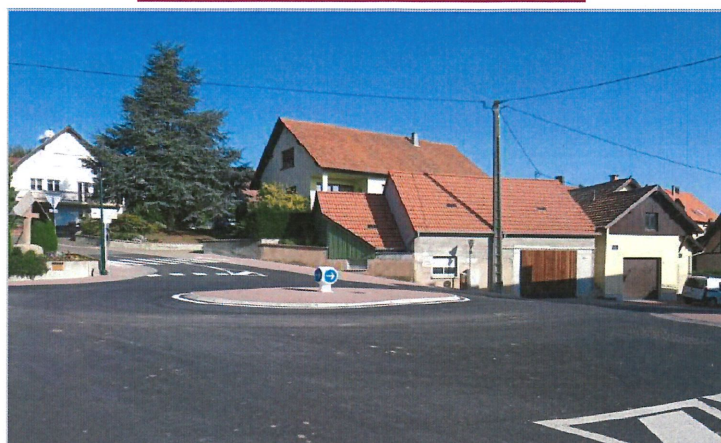
Aménagement du rond-point et du parking attenant
